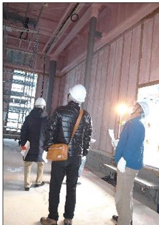
↓倉庫部分の見学の様子
