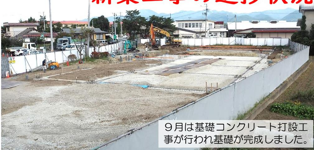
9月は基礎コンクリート打設工事が行われ基礎が完成しました。
